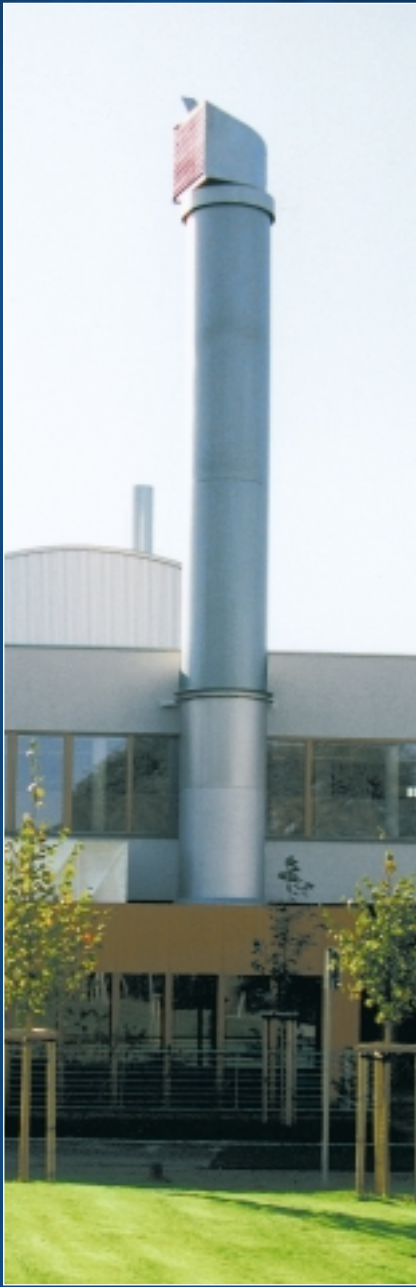
N1-SE 15 m Recklinghausen
