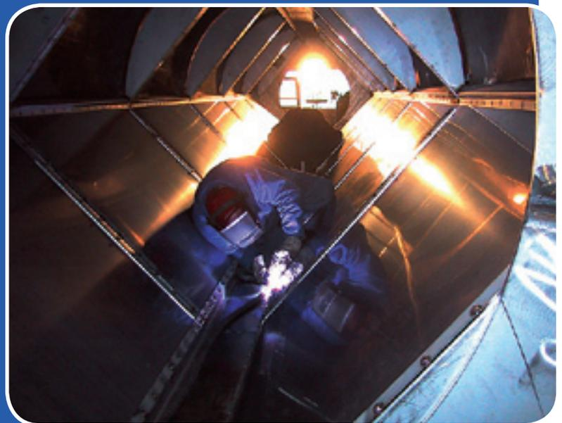
Glatte schwingfähige Platten werden als eckige Innenzüge in Schornsteine integriert, die anschließend Schallenergie in Schwingungsenergie umwandeln. Zudem sind sie gegenüber Verschmutzungen unempfindlich. Abgas- und Abluftanlagen kommen dadurch ohne zusätzliche Schalldämpfer aus.
