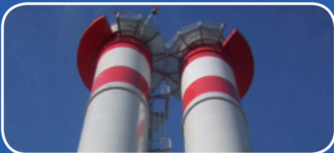
Wartungsfreie Schwingungsdämpfer reduzieren Querschwingungen oder schließen sie völlig aus. Nießing hat diese Schwingungsdämpfer gemeinsam mit der RWTH Aachen und dem Fraunhofer Institut entwickelt. Besonderheiten des Standortes (z. B. Erdbebenlasten, Seismik oder Starkwindereignisse) sind Bestandteil der Berechnungsgrundlage für die Auslegung.
