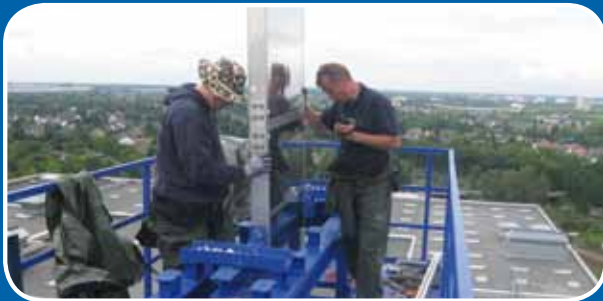
Einbau der 17,5 Meter hohen Plattenschwingersegmente in den Schacht.
