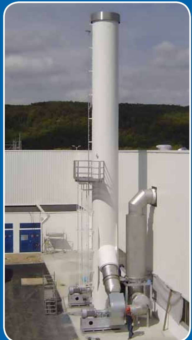
Nießing Abgassystem für Motorenprüfstände bei Renault
