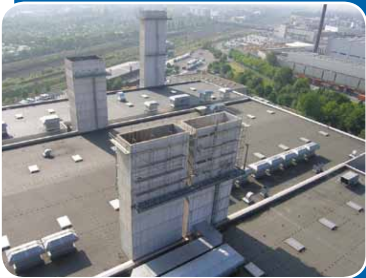
Außenansicht der beiden umzurüstenden Abluftkamine.
