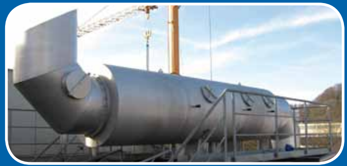
Hohlkammerresonator mit Reinigungseinrichtung
