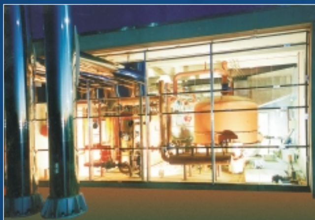
4 x N1-SE-E 20 m Integrierte Schalldämpfer Mont-Cenis, Herne
